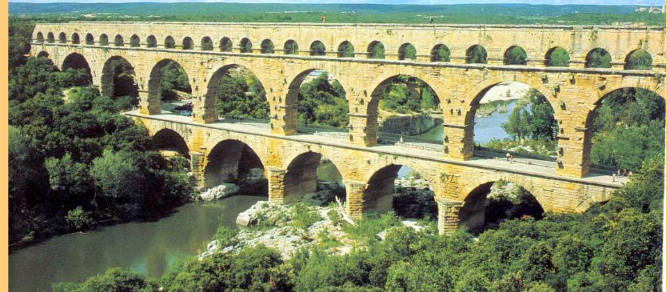
Ponte du Gard, Nîmes (França)
