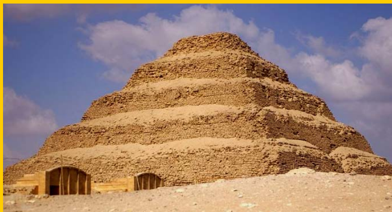
Imhotep ~ Pirâmide de Zoser, 3ª Dinastia (c. 2685 a.c.) c. 60 m altura, cercada por um muro de 10 m alt. e 1600 m comprimento
